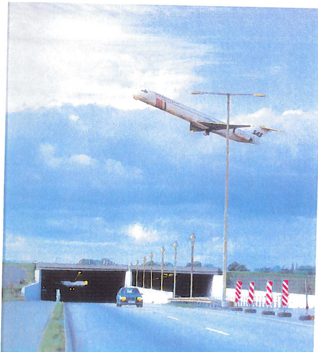
Transport udføres med forskellige transportmidler, der er tilpasset transportopgaven.
