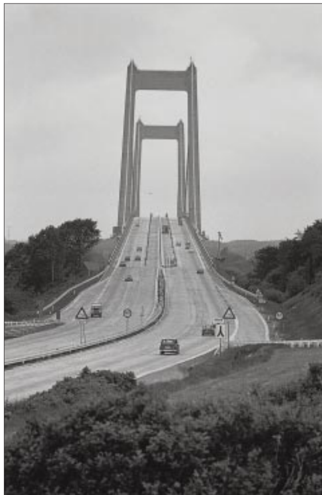
Lillebæltsbroen fra Jyllandssiden. Foto: Jens Frederiksen
