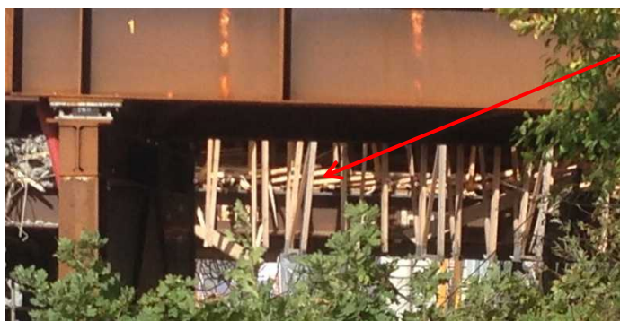
Figur 13. Skråt liggende gitterspærdele mellem girder 1 og 2 set fra syd
