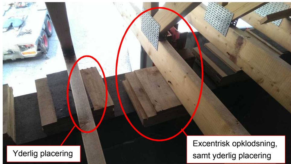
Figur 47. Excentriske og forskubbede opklodsninger, der er placeret yderligt.
