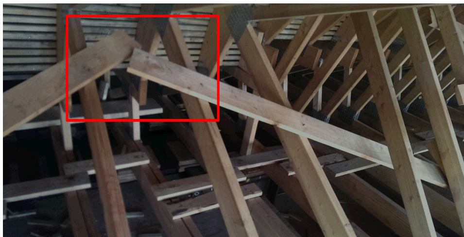
Figur 43. Afslutning af skrålægger et godt stykke under spærhoveder.
