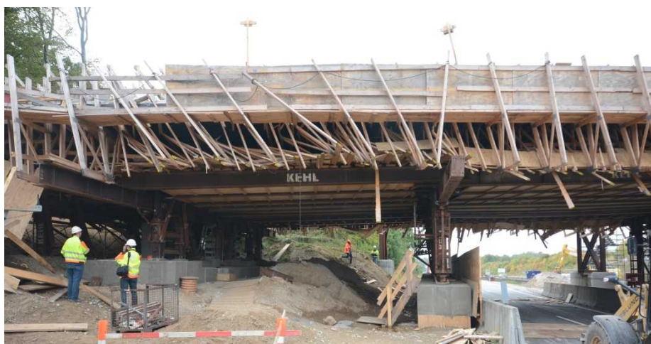
Figur 20 Facade mellem girder 2 og 3 set fra nord
