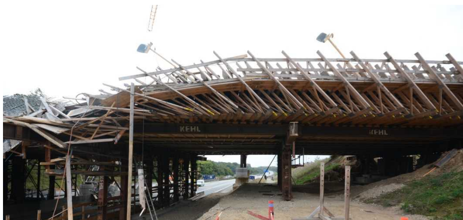
Figur 24 Den nordlige facade mellem girder 6 og 8
