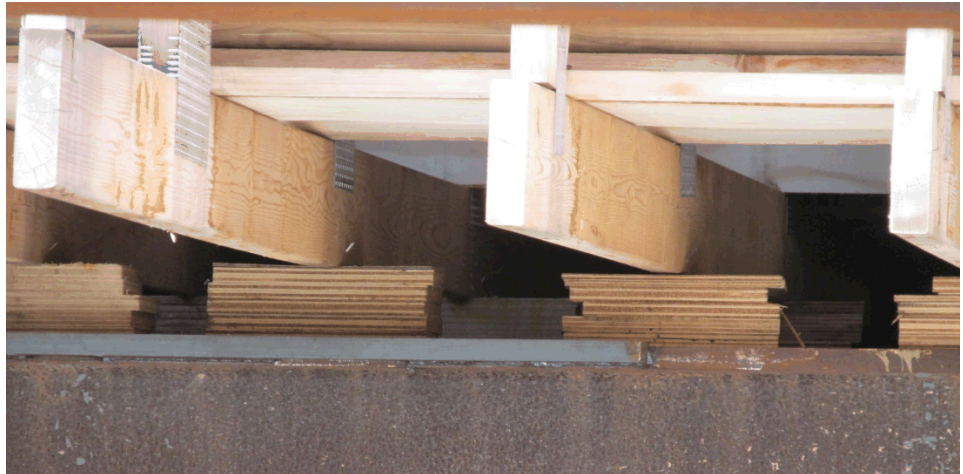
Figur 5. Foto af opklodsninger under spær
