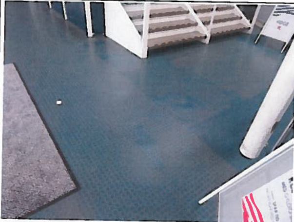
Foto 26: Afbleget gummigulv, dog intakt.
