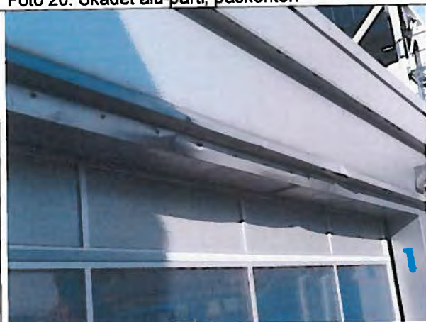
Foto 21: Påkørselsskadede portkarme.
