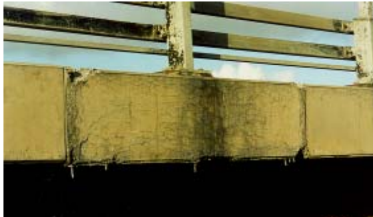
Figur 4.5.2.6. Eksempel på forvitrede kantbjælker
