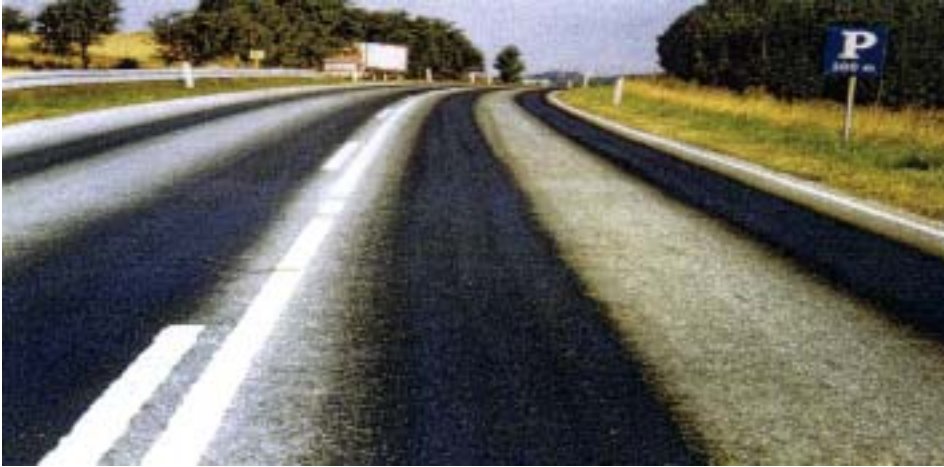
Figur 5.5.1. Gennemsveden belægning
