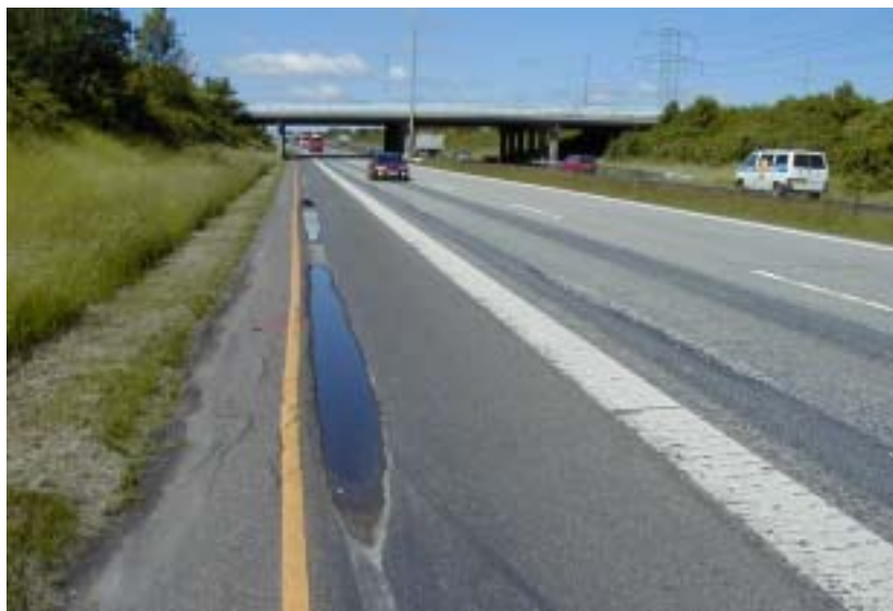
Figur 5.2.1.2. Ødelagte nødspor
