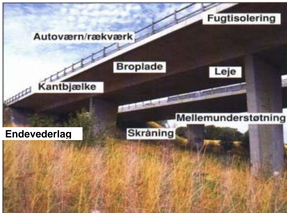
Figur 3.2.1.4. Typisk opbygning af motorvejsbro
