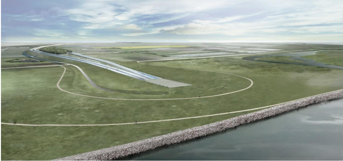
FIGUR 2.28 Portalbygning på Lolland set fra sydvest
