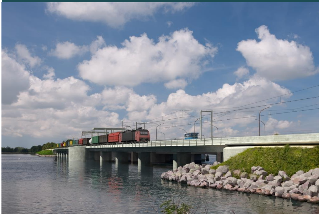
FIGUR 2.9 Over Guldborgsund anlægges en ny klapbro parallelt med Kong Frederik IX's Bro
