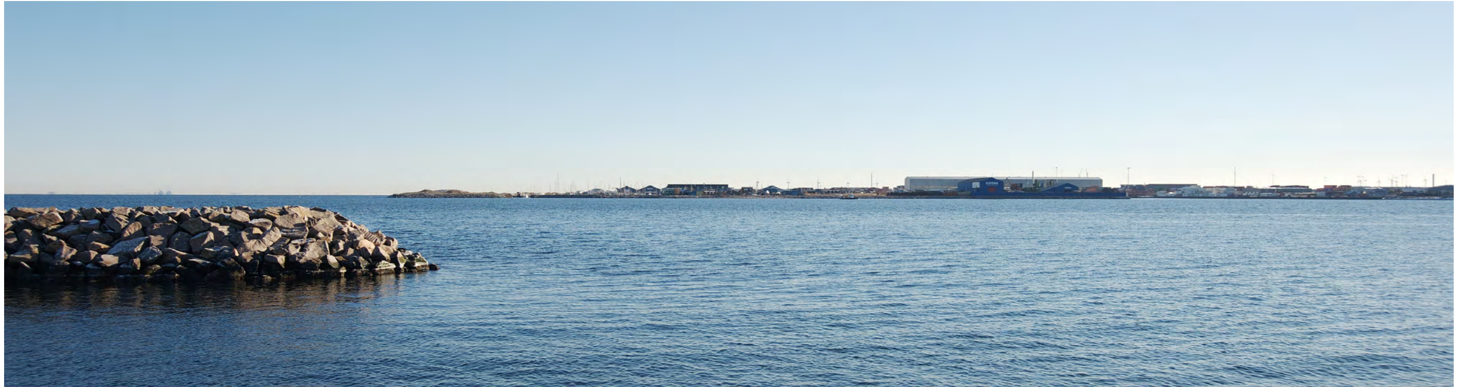
Eksisterende forhold set fra Tuborg Syd mod øst - dag. Optaget med vidvinkel. Havnefronten mod Tuborg Syd fremstår relativt lav og åben, domineret af enkelte større bygningsvolumener som den forhenværende tunnelementfabrikshal og de væsentligt mindre bygninger især i tilknytning til fiskerihavnen.
