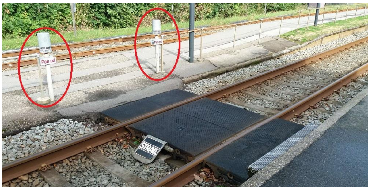
Billede 2: Varslingsanlæg på Ikast Station kun med lydvarsling
